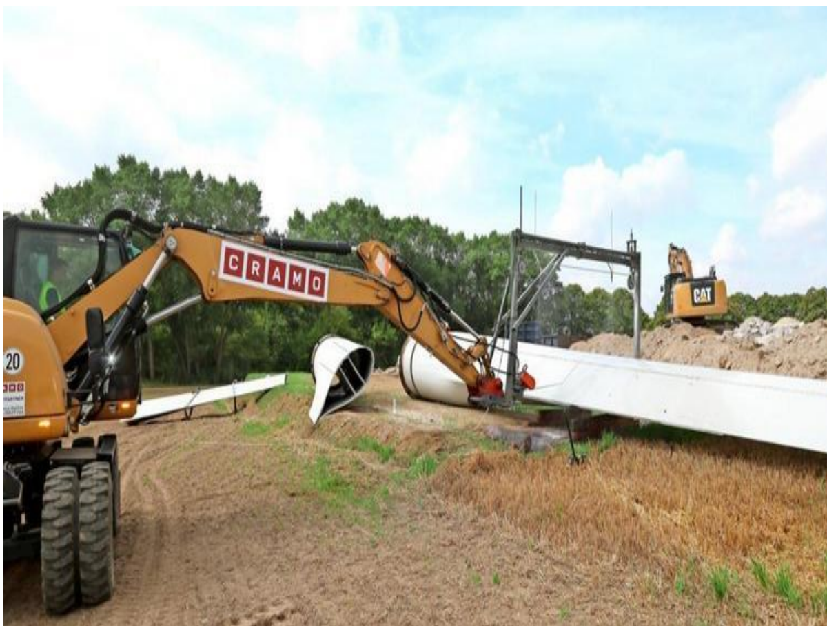
Rozbiórka w Bürgerwindpark Ravensberg / Krempin - cięcie łopaty turbiny wiatrowej. Źródło: Thomas Hoppe
